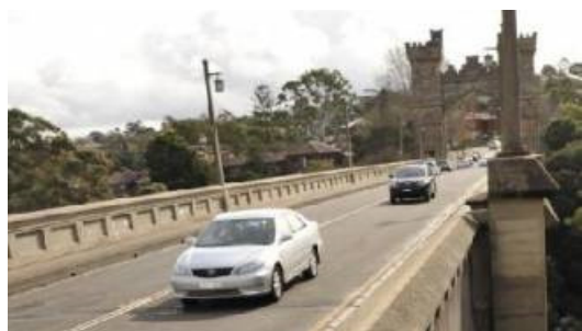
RISK: Long Gully Bridge.
